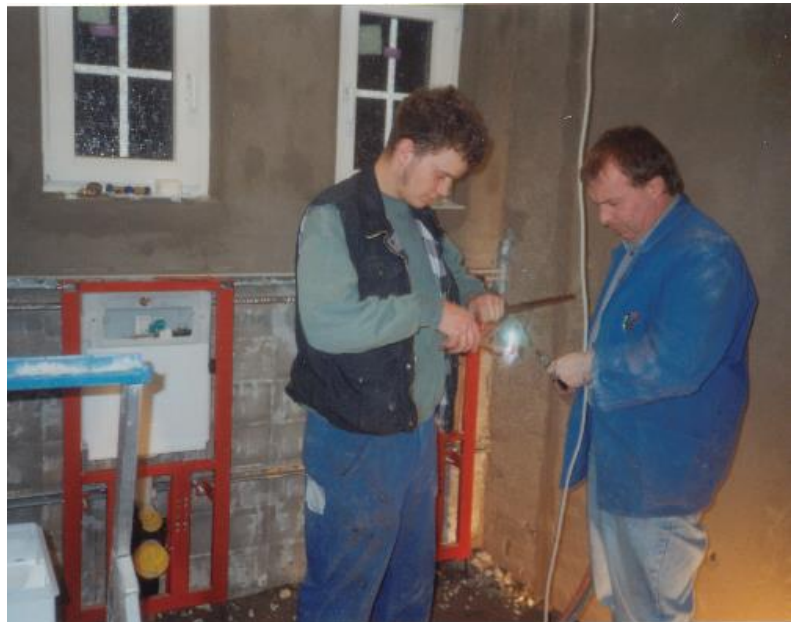
Wasserinstallation in der neuen Toilet- teanlage
