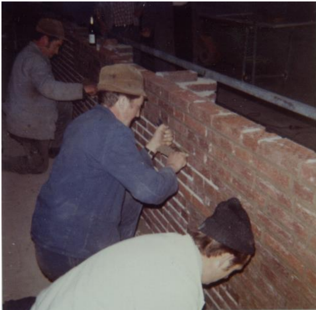
Thekenbau 1973, Aufziehen Handlauf
