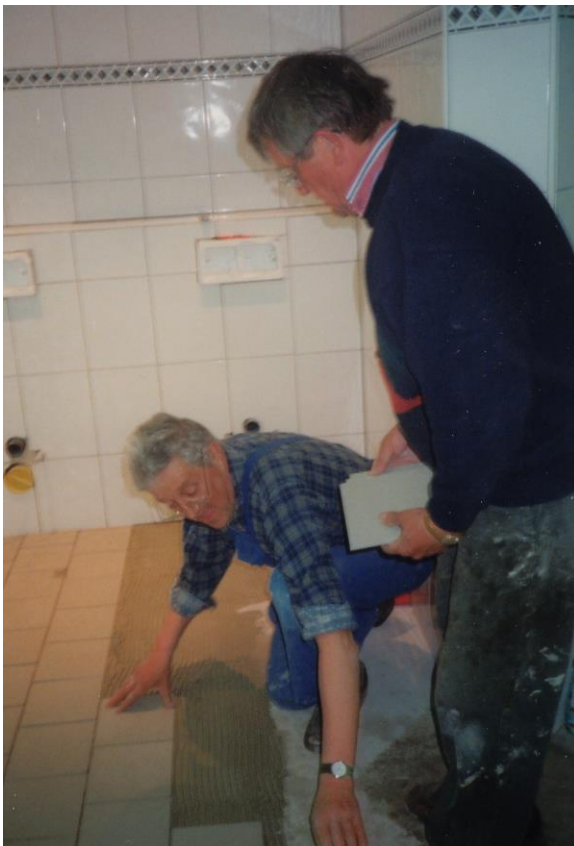
Werner Muckermann und Siegfried Kraft beim Neubau der Toiletten im Jahr 2000
